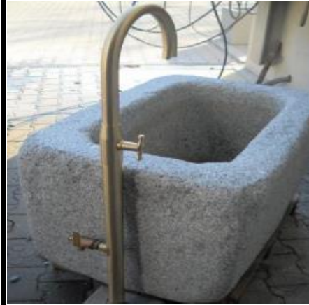
Ventiel + Kugelhahn unten
